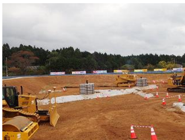
重機による埋立作業の確認
