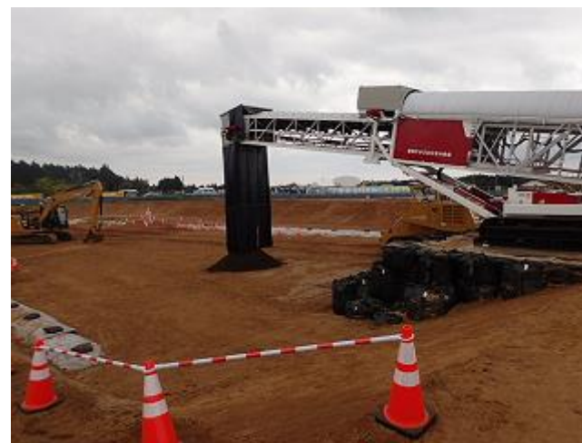
汚染土の搬入状況の確認
