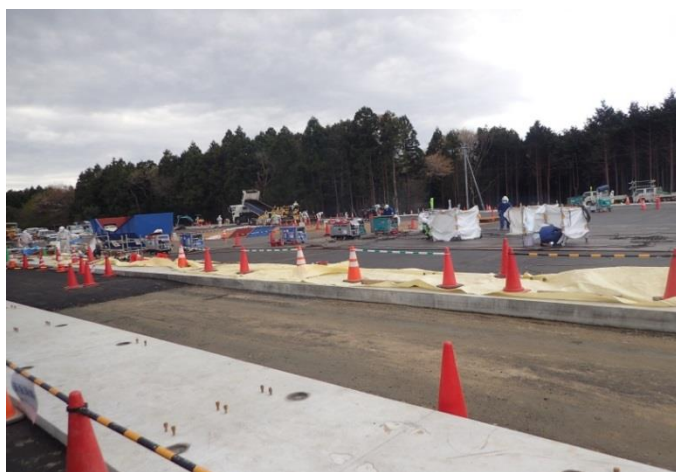
大熊工区受入・分別処理施設設置場所の確認
