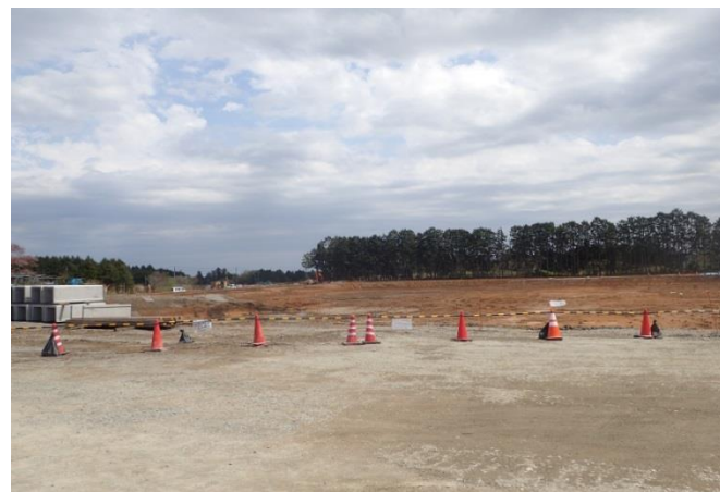
大熊工区土壌貯蔵施設設置場所の確認
