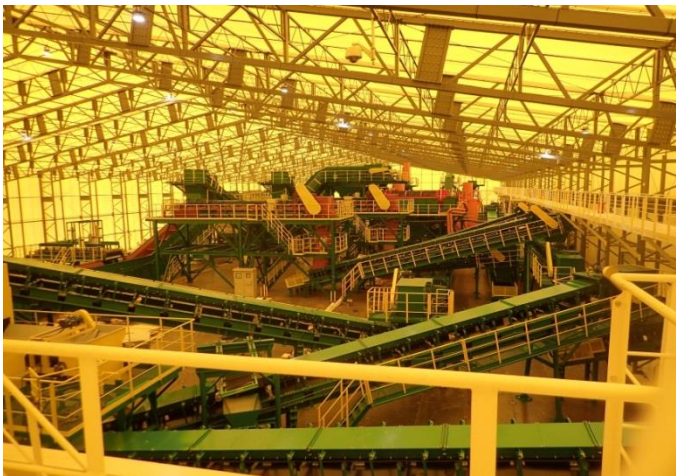
双葉工区受入・分別処理施設の確認
