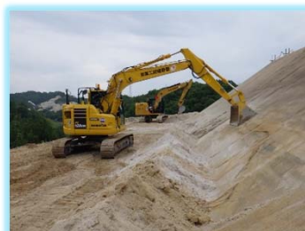
セミオート法面整形
