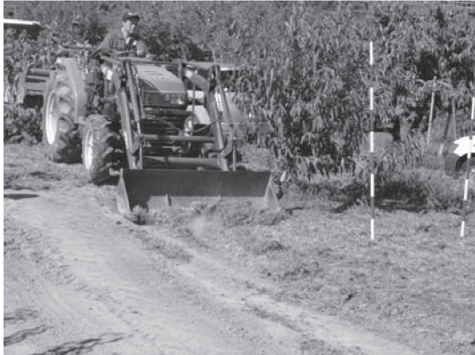
図 7 表土剥ぎ取り・押土作業
