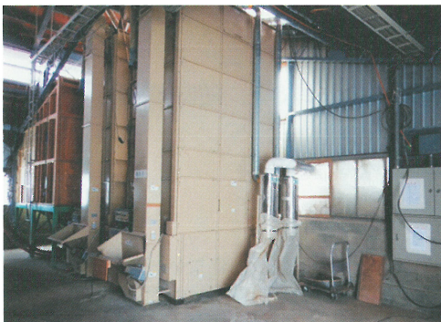
整理・整頓・清掃された乾燥調製施設
