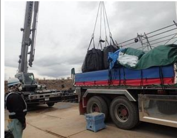
除去土壌等の積み込み作業確認
