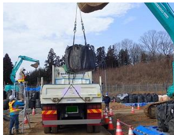
除去土壌等の積み込み作業確認
