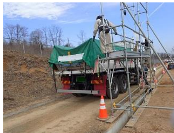
除去土壌等の積み込み作業確認
