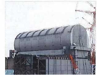
3号機燃料取り出し用カバー
