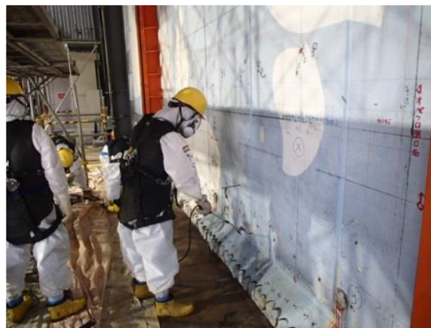
縦列コア削孔前飛散防止剤散布状況
