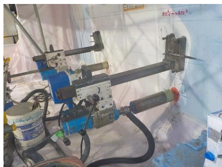
コア削孔装置設置状況
