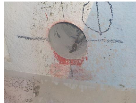
コアを削孔した状況
