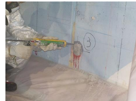
削孔箇所の孔塞ぎの状況
