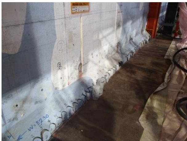
横列解体用コア削孔状況
