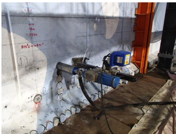
縦列解体用コア削孔装置設置状況
