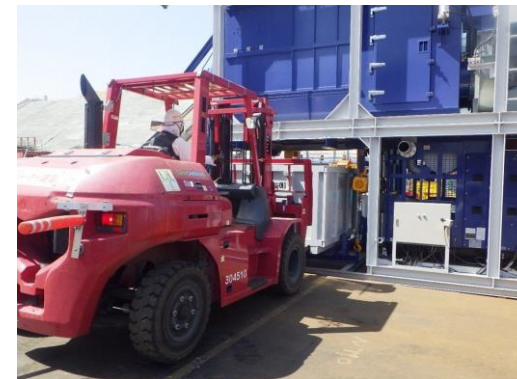
③ 吸引装置からガレキ回収コンテナを取り外す
