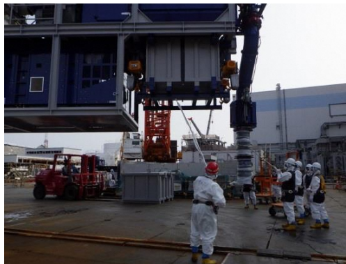
② 吸引装置をクレーンでヤードに降ろし、ガレキ回収コンテナの線量率を測定する
