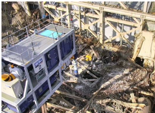
① 吸引装置でガレキを吸引 吸引したガレキは、吸引装置に取り付けたガレキ回収コンテナに収容する
