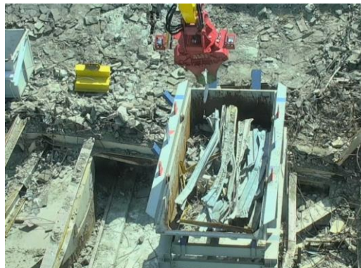
② オペフロでガレキ収納箱にガレキを集積
