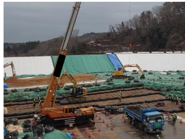
下流側埋立地の埋立状況の確認
