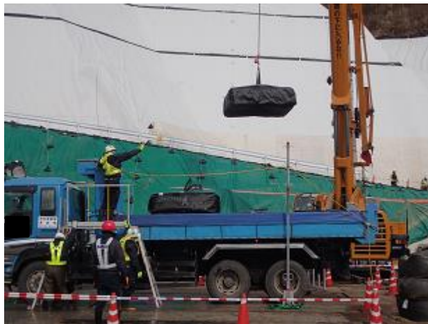
特定廃棄物の搬入状況の確認
