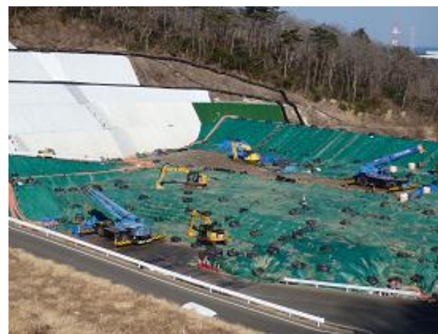
下流側埋立地の埋立状況の確認
