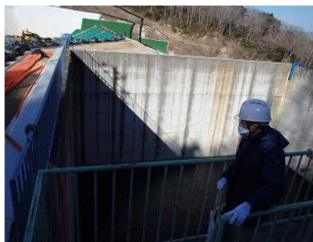
浸出水調整槽の状況の確認
