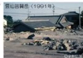
降灰後の土石流
