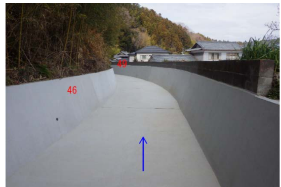
竣工 (平成30年3月)
