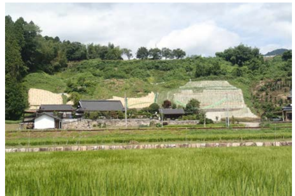
竣工 (平成29年8月)
