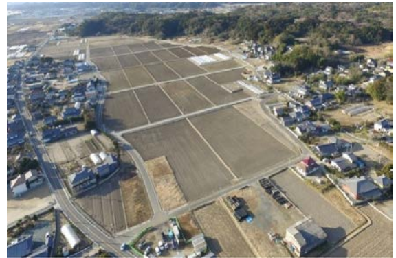
竣工 (平成30年3月)
