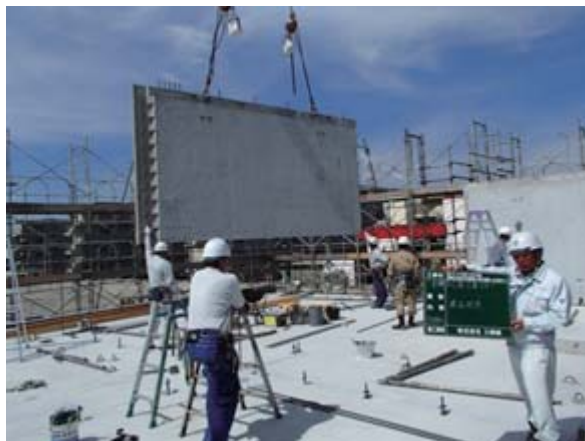
PC建込み状況
