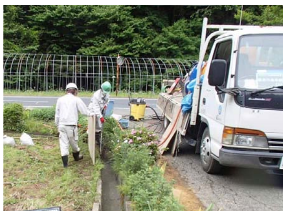
側溝除染作業中
