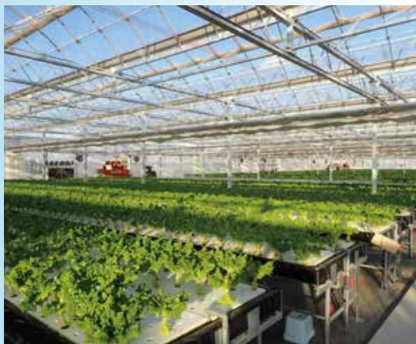
施設の特長は、環境要素（照度、炭酸ガス、気温、湿度）の測定結果に合わせて、換気窓、カーテン、暖房機、養液栽培装置などをコンピュータが制御し、栽培する作物の生育に最適な環境を保ちながら高品質な野菜の安定供給を目指しています。また、県内でも新しい養液システムである噴霧型水耕（根に養液を拭きかける方式）によるトマト栽培を行っております。
