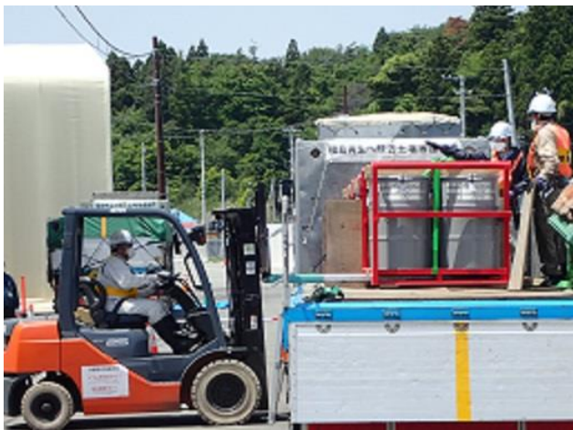
輸送物の積込作業確認
