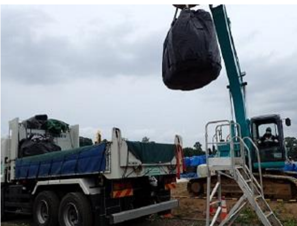
輸送物の積込作業確認
