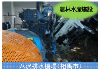
八沢排水機場（相馬市）
