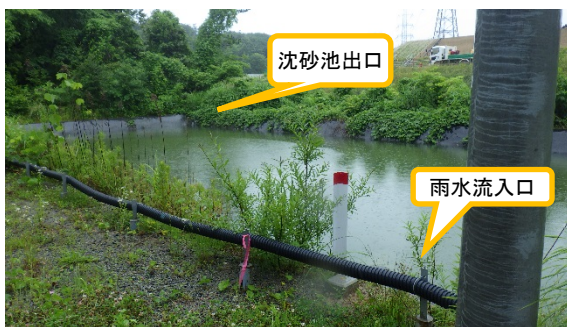
(写真 4) 沈砂池の状況 (北東側から撮影)
