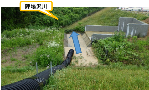
(写真 3) 廃棄物関連施設設置予定地の東側エリア造成現場からの雨水排水状況 (北東側から撮影)
