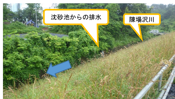
(写真 5) 沈砂池からの排水状況 (西側から撮影)
