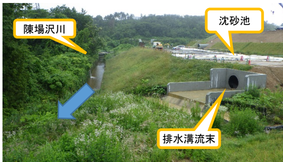
(写真 2) 排水溝流末の状況 (北東側から撮影)
