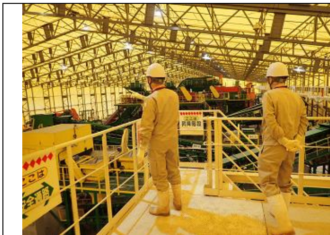
受入・分別施設の稼働状況の確認
