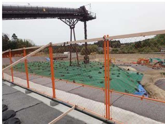
土壌貯蔵施設の稼働状況の確認
