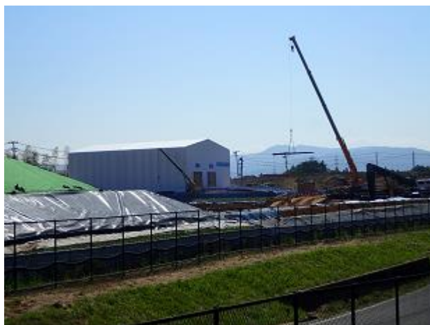
土壌貯蔵施設拡張部分の設置状況の確認
