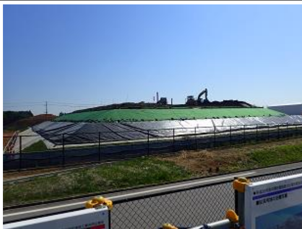
土壌貯蔵施設の稼働状況の確認
