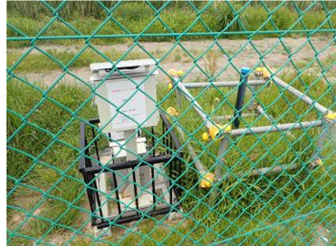
保管場におけるモニタリング状況の確認
