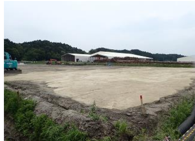
保管場の設置状況の確認
