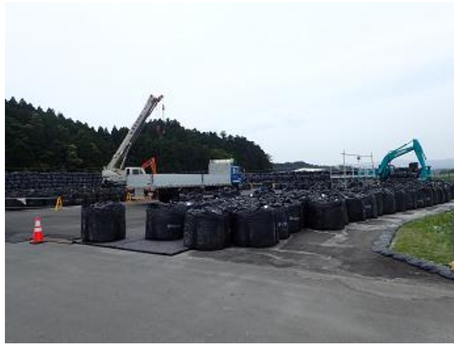
保管場における汚染土壌の保管状況の確認
