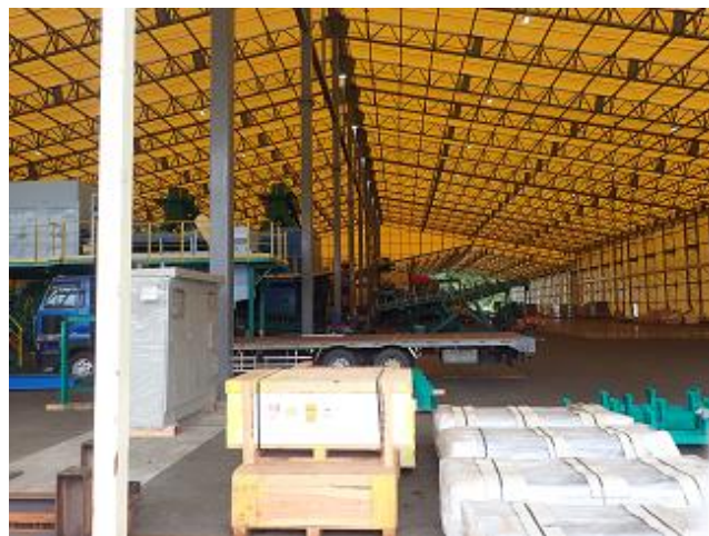
受入・分別施設の設置状況の確認
