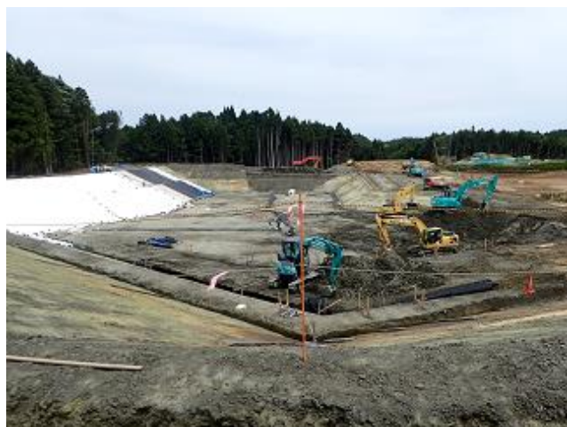
土壌貯蔵施設の設置状況の確認
