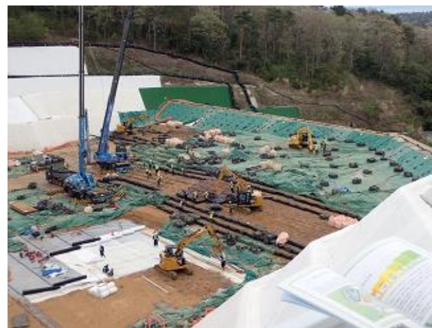
下流側埋立地の埋立状況の確認
