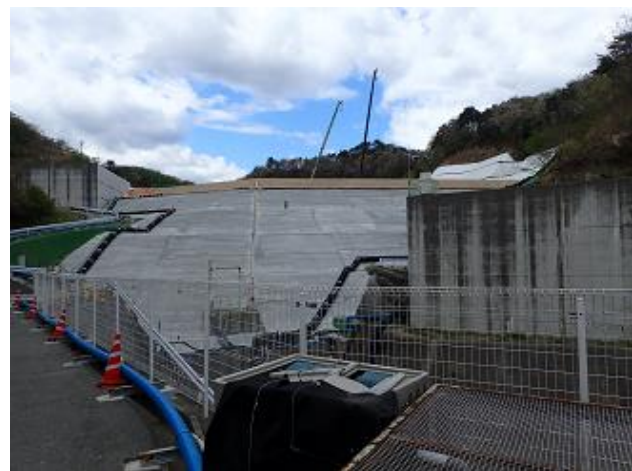
堰堤の状況の確認
