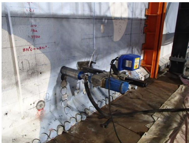
解体用コア削孔（STEP3）
