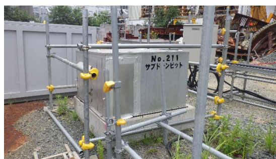
(写真2-2) 新設ピットNo.211の状況
