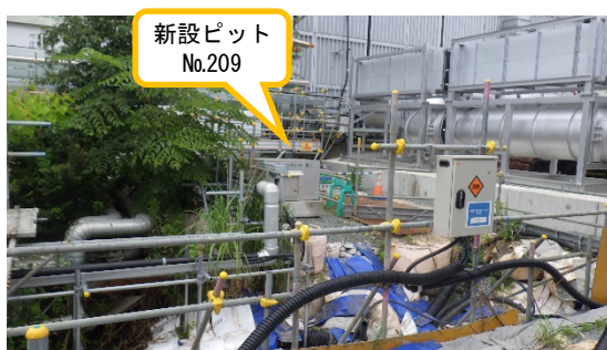
(写真2-1) 新設ピットNo.209の状況
