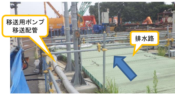
(写真1-2) 電動開閉ゲートBC-1の排水移送用ポンプ、発電機等の 配備状況（西側から撮影）
