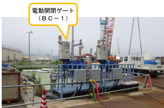
(写真1-1) 電動開閉ゲート (BC-1) の状況 (東側から撮影)
