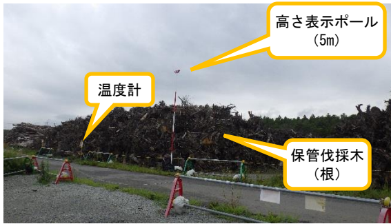
(写真1-2) 一時保管エリアGの状況② (エリア中央を東側から撮影)
