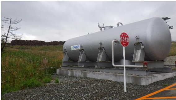
(写真2) 一時保管エリアGに追加設置された防火水槽の状況 (北側出入口付近(東側から撮影))
