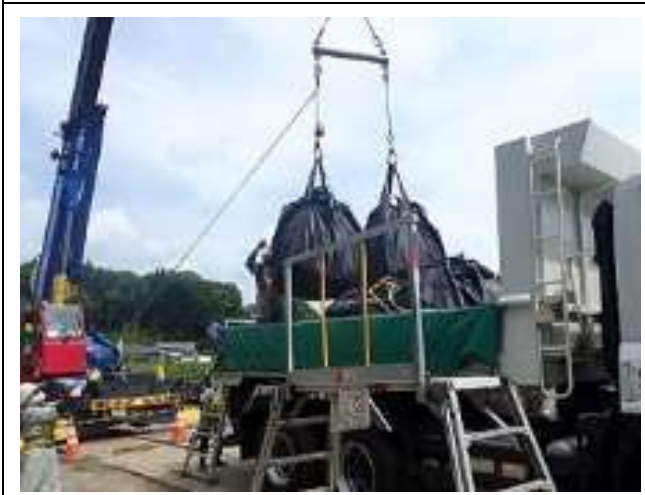
輸送物の積込作業確認
