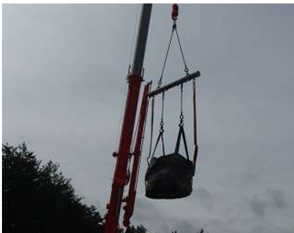
輸送物の積込作業確認
