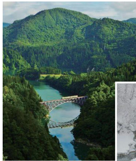
▲只見川第1橋りょう（三島町）
