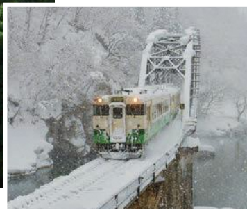
只見川第4橋りょう（金山町）▲
