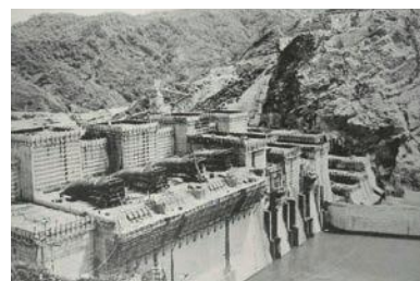
建設中の田子倉ダム(只見町) ▲
