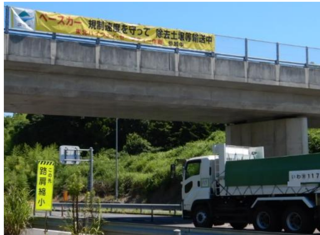
除去土壌等の輸送に対する理解促進のための横断幕の下を走行する輸送車両
