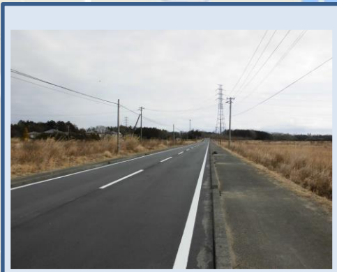
改良工事後の道路の様子(町道東17号線)
