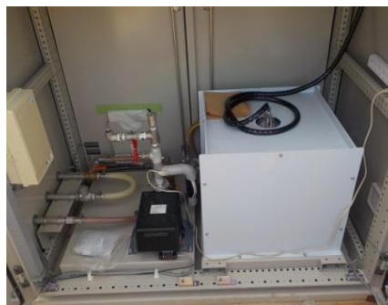
検出槽(1期双葉工区)
