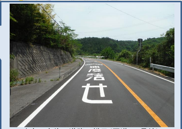
改良工事後の道路の様子(国道288号線)
