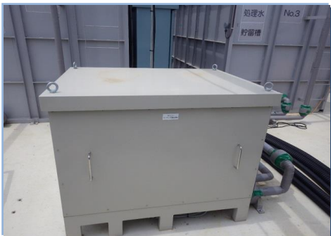
検出槽(1期大熊工区)
