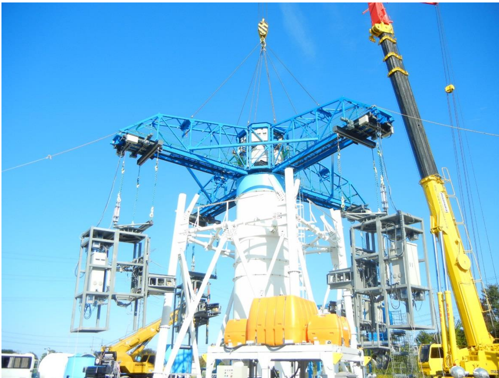
③ 排気筒模擬施設上部で位置決めをしている鉄塔解体装置
