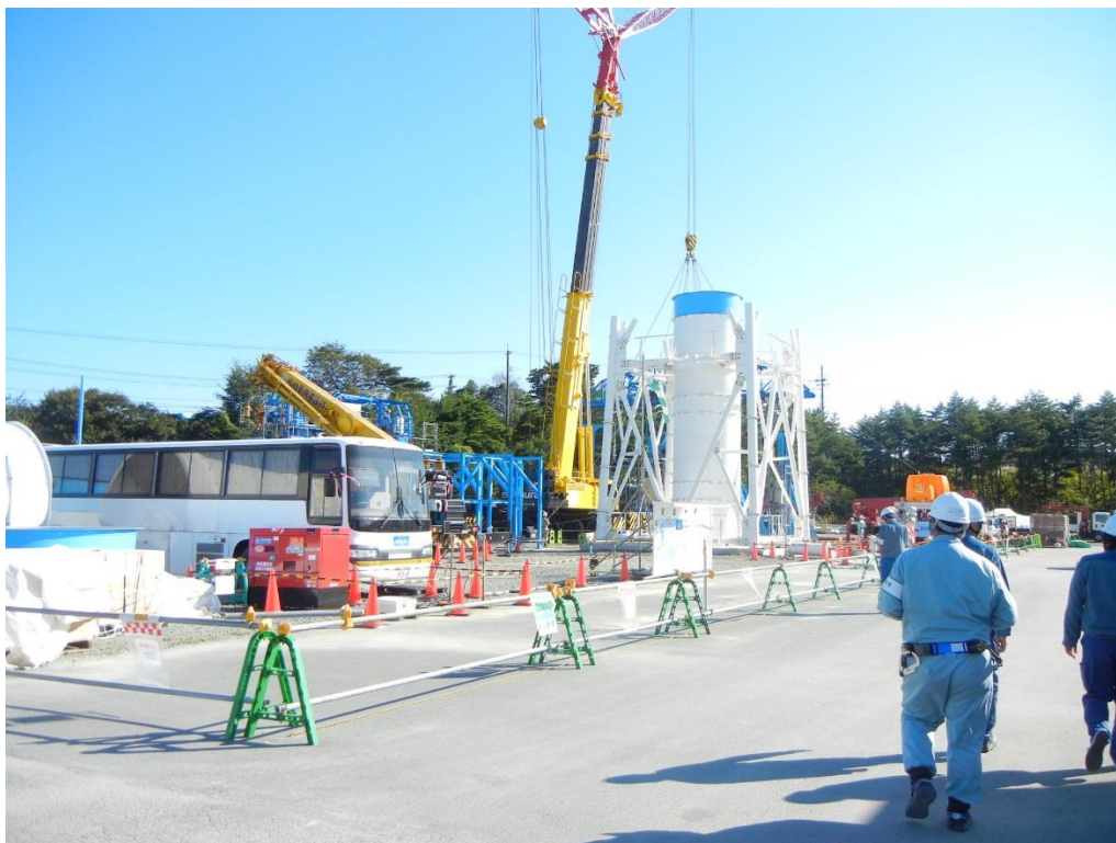
① 排気筒模擬施設外観
