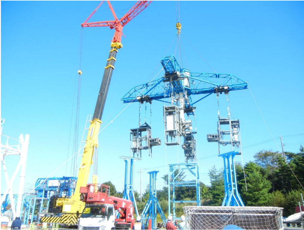
② クレーンで吊り上げた鉄塔解体装置の外観
