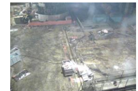
② 残置物片付け後 (北側) 撮影日 (10/22)
