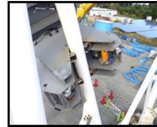
斜材切断装置切断状況
