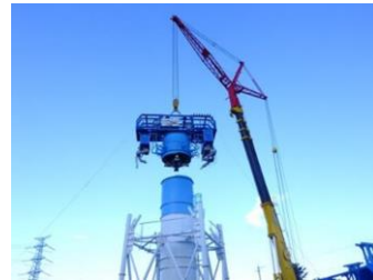
解体部材揚重状況
