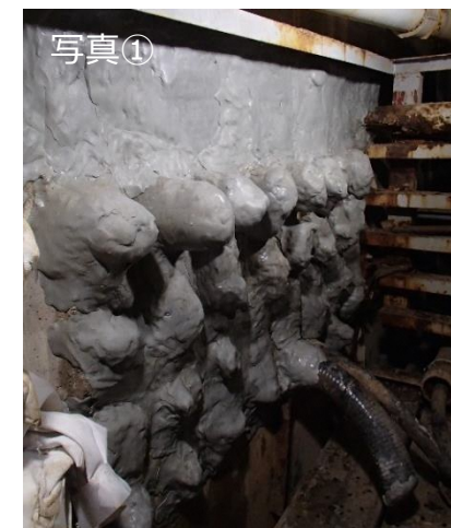
1号機共通配管トレンチ貫通箇所 止水状況
