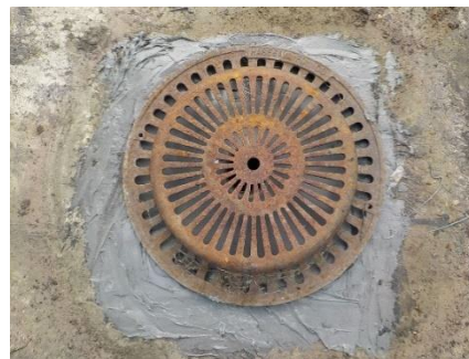
②ルーフドレン改修完了
