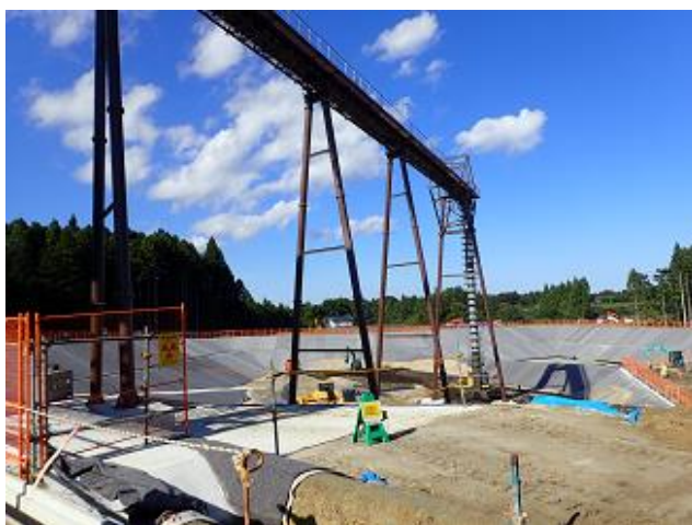
土壌貯蔵施設の稼働状況の確認
