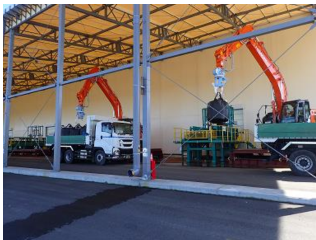
受入・分別施設への除去土壌の搬入
