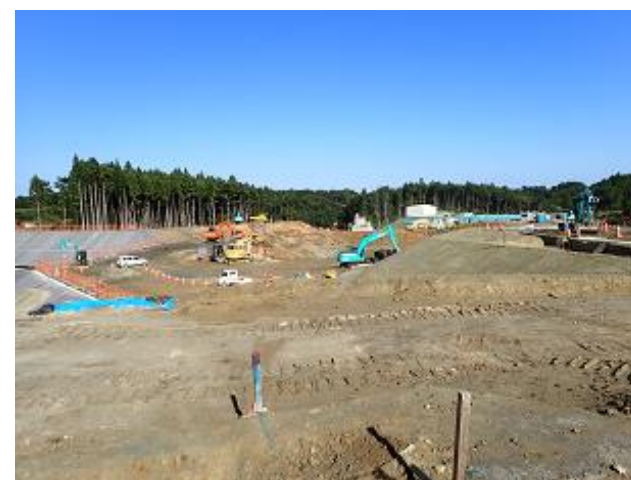
土壌貯蔵施設の設置状況の確認
