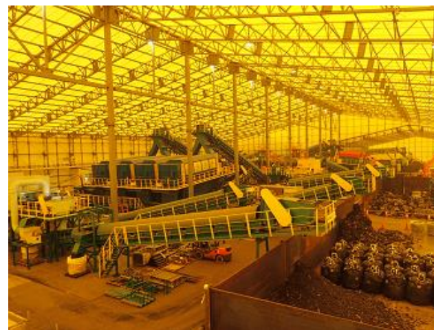
受入・分別施設の稼働状況の確認
