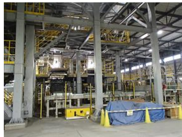
焼却灰充填機の状況の確認
