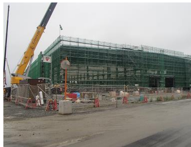
設置工事中の灰保管施設
