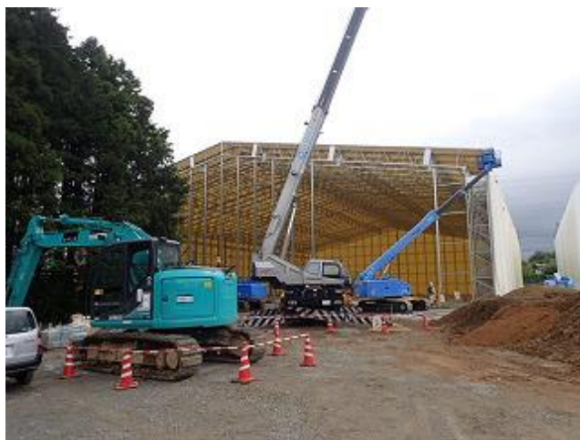
灰保管施設の設置状況の確認
