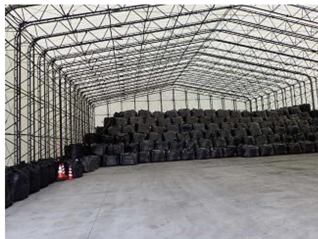
灰の保管状況の確認
