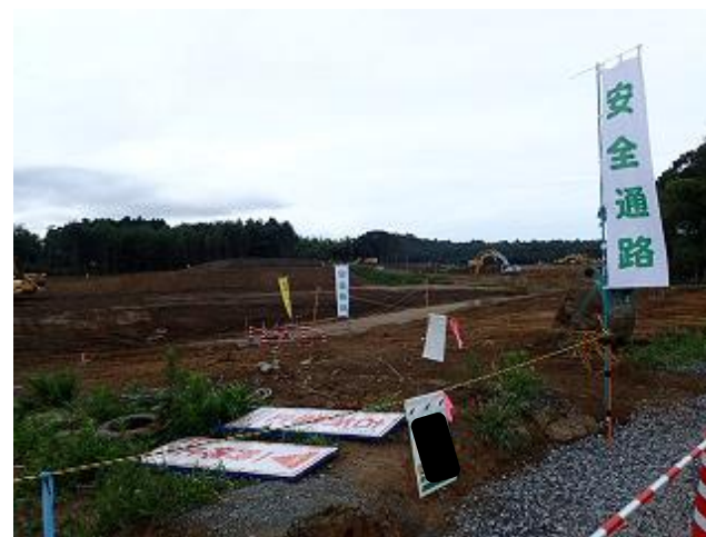
灰保管施設の設置状況の確認
