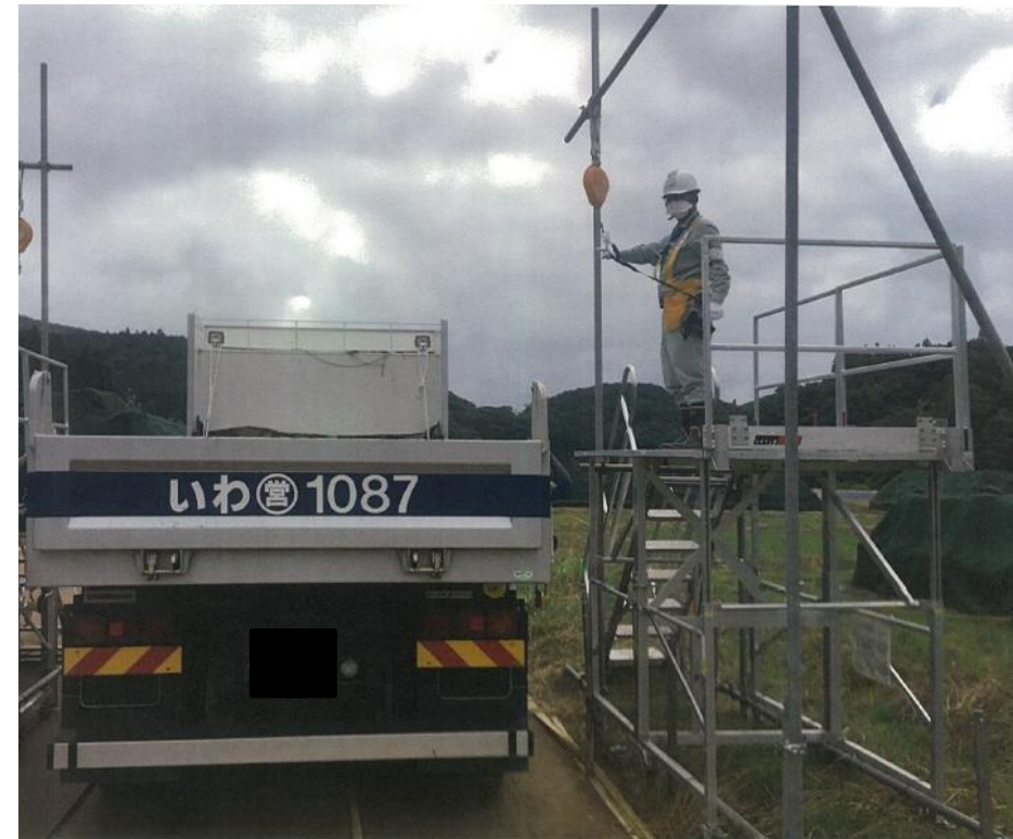
事故の発生現場の作業風景
