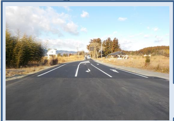
改良工事後の道路の様子(県道251号線)
