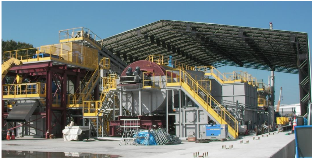
【工事現状 (2018年10月26日撮影)】
