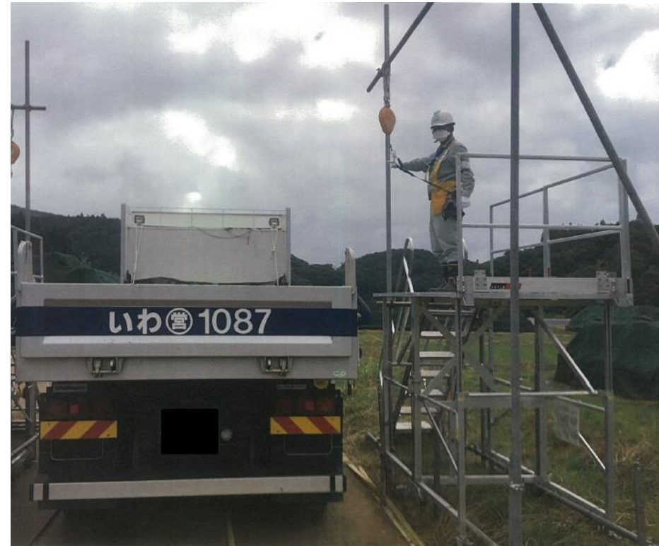
事故の発生現場の作業風景
