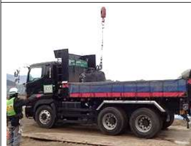
輸送物の積込作業確認
