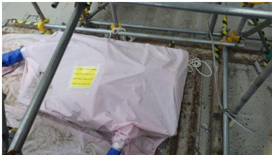
(写真3) 養生の状況
