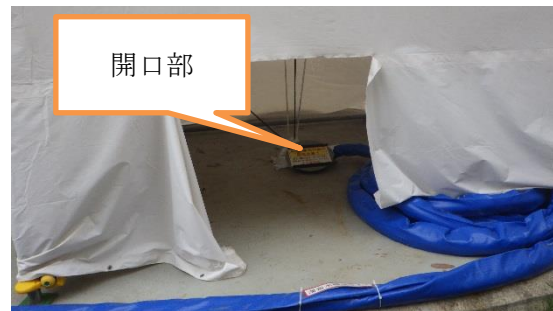
(写真4) 滞留水を移送するホースが出ている開口部
