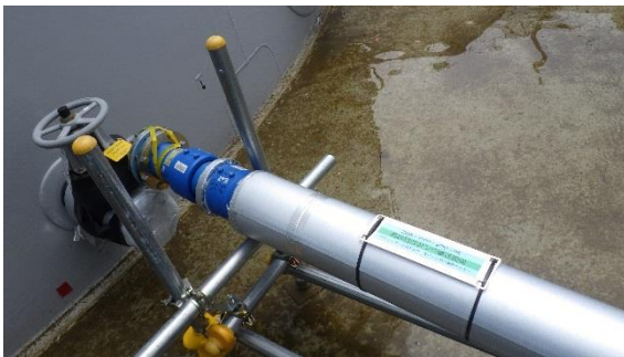
(写真2-1) H1-1 タンクの払出配管の敷設状況①
