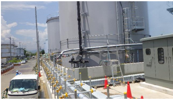
(写真 2 - 3) H1-1 タンクの受入配管の敷設状況
