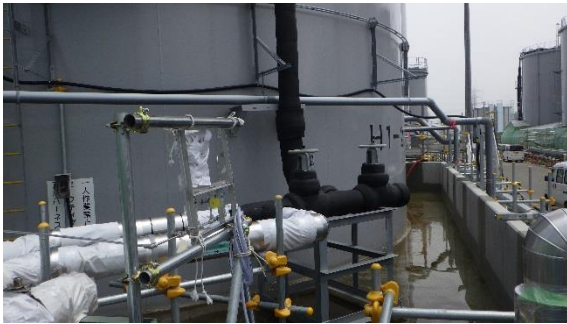
(写真 3 - 1) H1-2 タンクの受入配管の敷設状況
