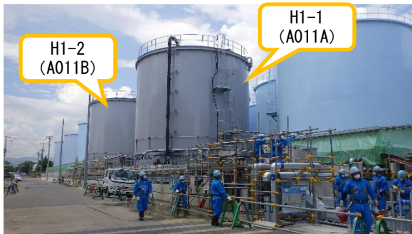
(写真4) 配管敷設作業の状況 (南東側から撮影)
