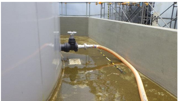
(写真 3 - 3) H1-2 タンクの払出配管の敷設状況②
