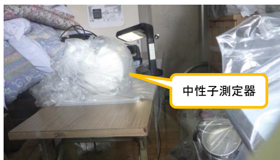
(写真5-2) 西門守衛所内の中性子測定器の状況
