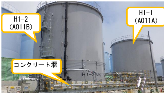
(写真1) H1 東エリア西側の雨水回収タンクの状況 (南西側から撮影)
