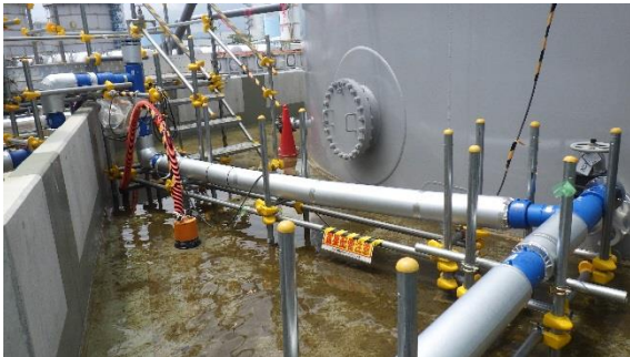
(写真 3 - 2) H1-2 タンクの払出配管の敷設状況①
