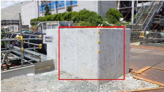
(写真1) 赤枠が集水升
