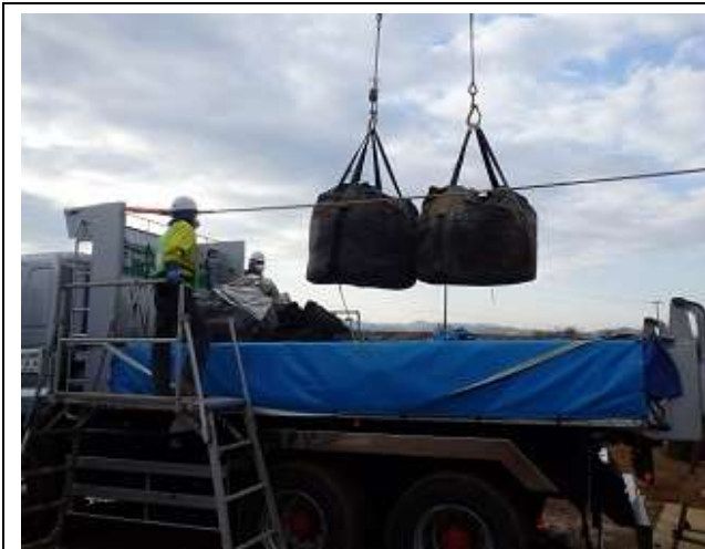
輸送物の積込作業確認
