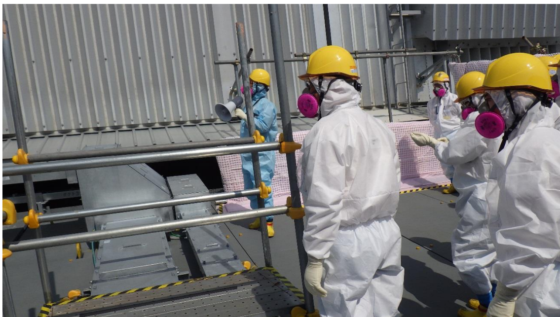
③ 3号機原子炉建屋オペレーティングフロアでの確認状況。市町村職員が燃料取扱機／クレーン不具合対策として実施されたケーブル交換箇所等の確認している様子。
