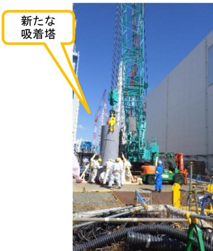
(写真2-1) 慎重に架台（チルローラー）に吊り下ろしている状況
