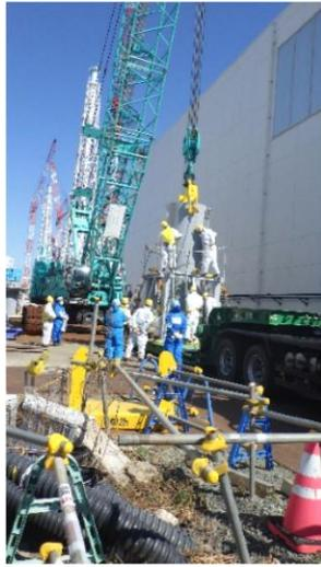
(写真1-2) 慎重に架台（移動車両用）に吊り下ろしている状況
