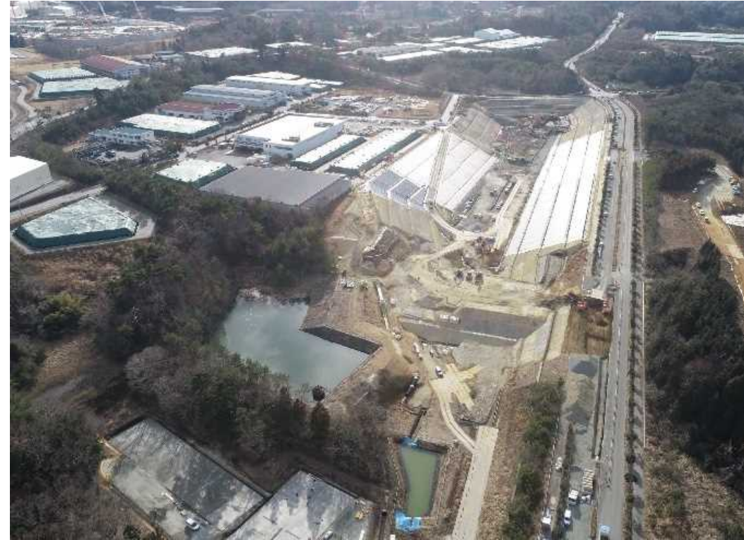
土壌貯蔵施設(整備中)
