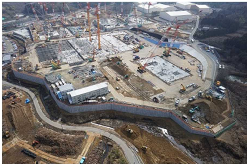
ヤード全景：3月5日現在
