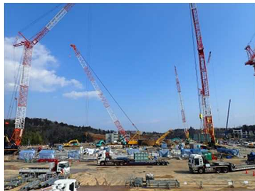
仮設焼却施設：基礎工事
