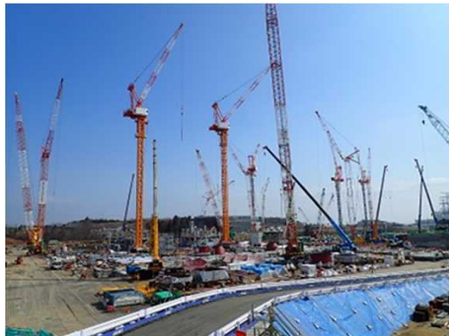
仮設灰処理施設：基礎工事
