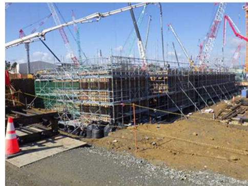
仮設焼却施設：基礎工事
