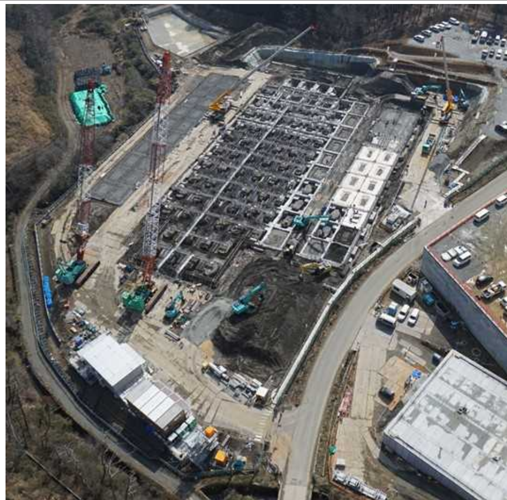
北側（写真下）より基礎・1階床躯体工事状況
