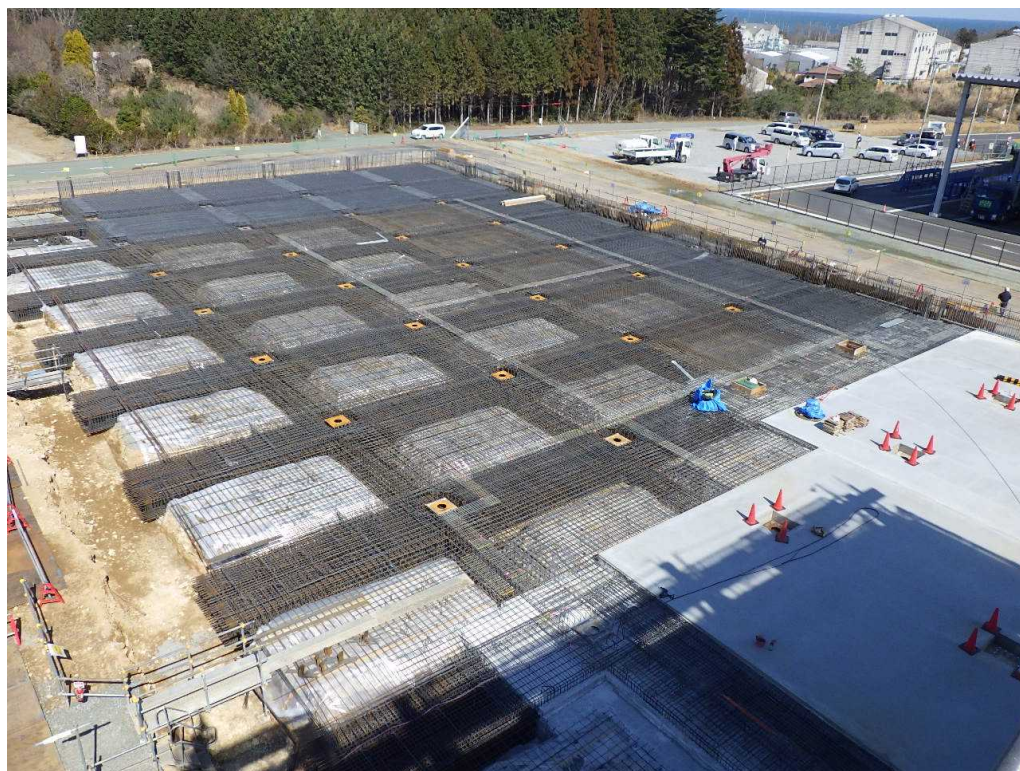
荷下し場より定置場①の基礎工事状況
