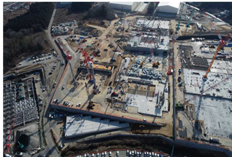
ヤード全景：3月1日現在
