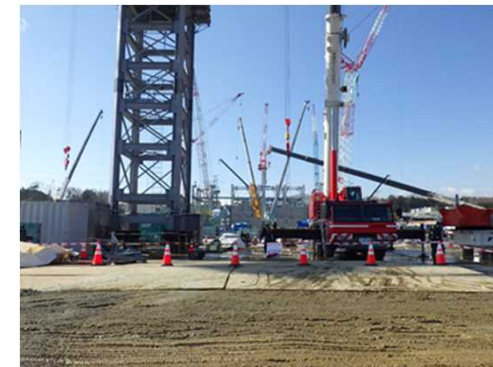
仮設灰処理施設：基礎工事
